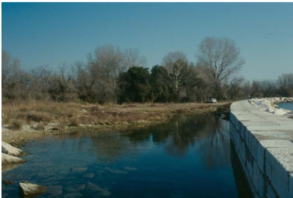
Fig. 6 - Pozze di sifonamento. Area denominata "3" in Fig.1. Vista da Ovest del sistema di pozze maggiori.
