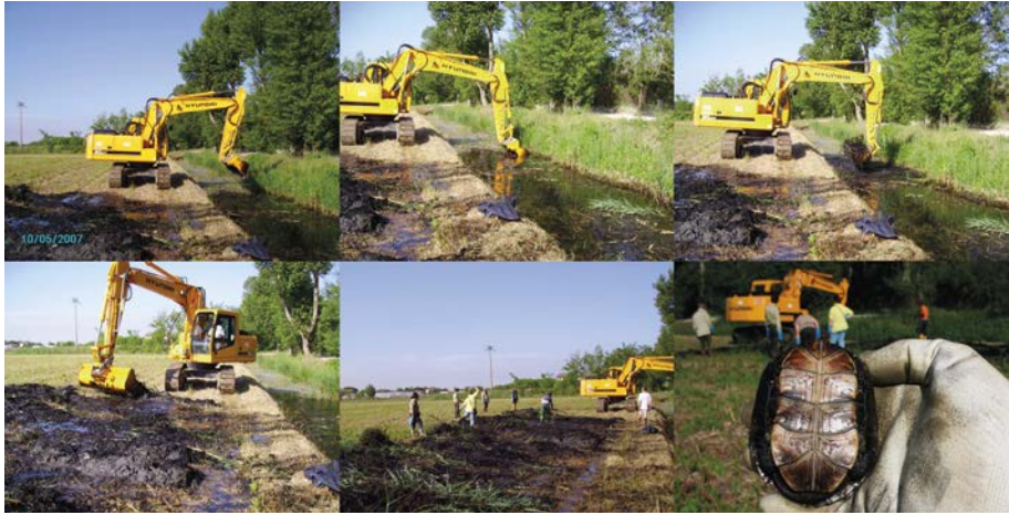
Fig. 1. Sequenza di scavo, deposito e stesura del fango e recupero delle testuggini nel sito del “Basson” a Punta Sabbioni (foto: F. Berton).
